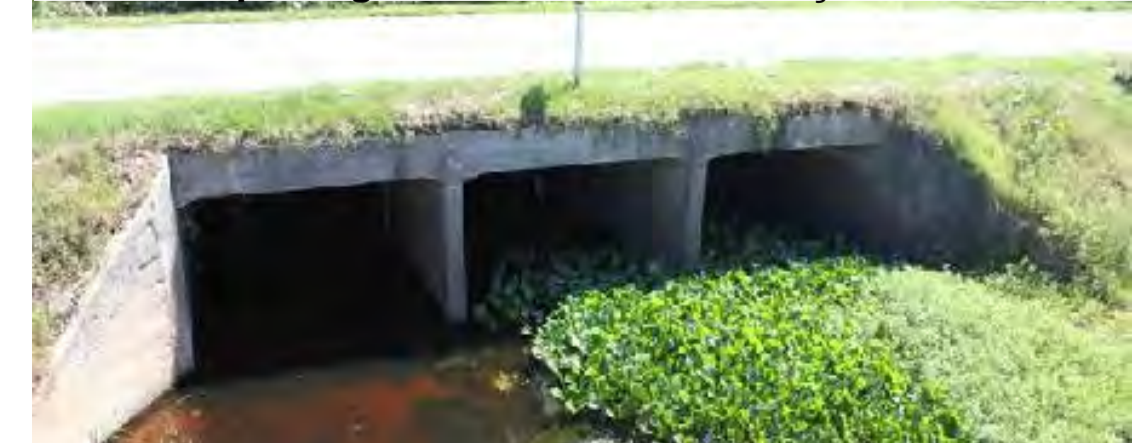
Galeria de passagem do Arroio das Cabeças sob a BR 392
