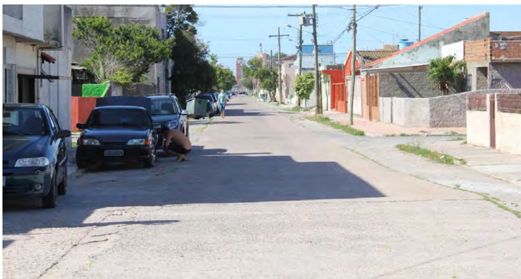
Figura 5.4: Galeria fechada sob a Rua Acácia Riograndense
