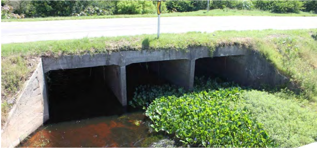
Figura 5.17: Galeria de passagem do arroio das Cabeças sob a BR 392
