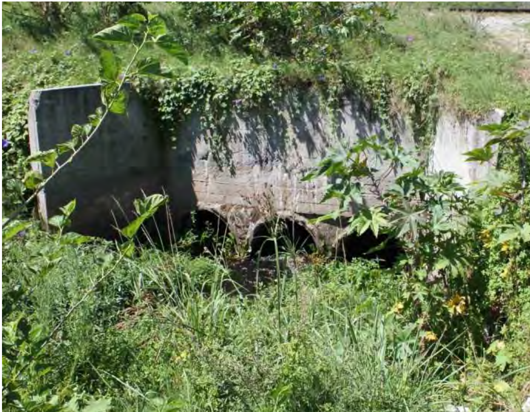
Figura 5.19: Bueiro junto à passagem do arroio das Cabeças sob a estrada de ferro
